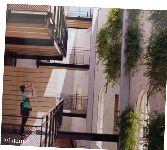
reconversion d'un ancien cinéma en 16 logements sociaux et bureaux à Saintes (17)
