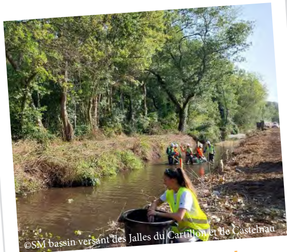
©SM bassin versant des Jalles du Cartillon et de Castelnaud restauration hydromorphologique et des continuités écologiques des jalles (33)
