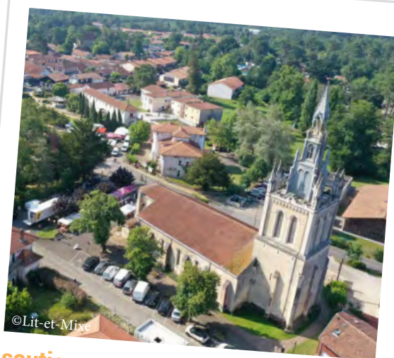
soutien aux planifications locales d'adaptation et de gestion durable Commune de Lit-et-Mixe (40)
