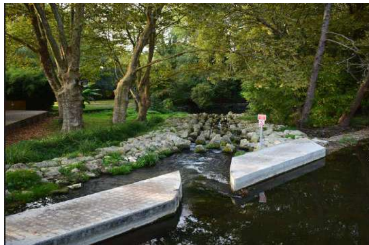
Figure 15 : Passe à poissons, chaussée « Vandier », en aval de la Roussille © Odile Cardot
