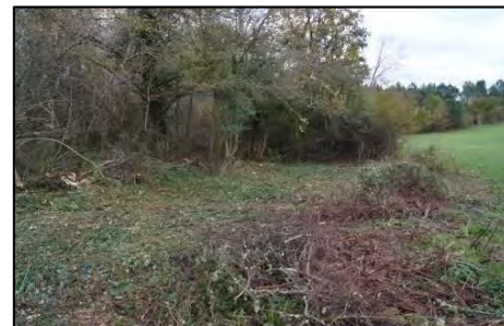
Travaux sur la lisière -2013
